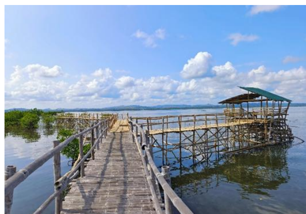
歩行困難な植林地に作業道を建設
